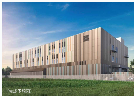
(完成予想図) 北海道石狩市における再エネ100%で運営するデータセンター
