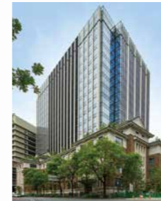
九段会館テラス 東京都千代田区
