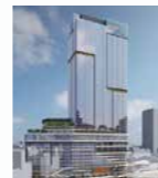
新宿駅西口地区 開発計画 新宿区 商業/業務/駅施設等 延床面積:251千㎡(A区) 2029年度竣工予定
