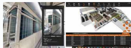
デジタル空間上で施設情報の確認・不具合情報を管理
