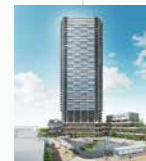
THE TOWER JUJO (ザ・タワー十条) 2024年9月竣工予定
