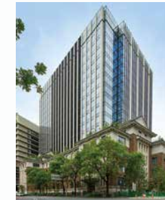
九段会館テラス 東京都千代田区
