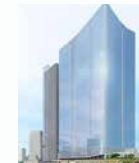
日本橋一丁目東地区 再開発事業 中央区 商業/業務/カンパレンス等 延床面積:274千㎡(A街区) 2031年度竣工予定
