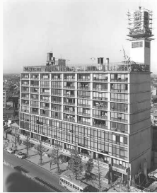
東急スカイライン(分譲集合住宅)
