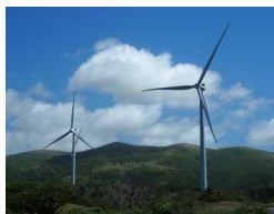
リエネ松前風力発電所
