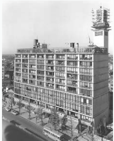
東急スカイライン(分譲集合住宅)
