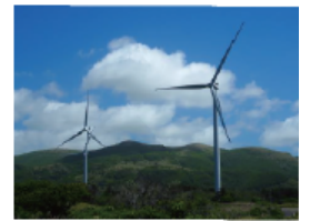
リネ松前風力発電所
