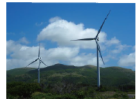
リネ松前風力発電所
