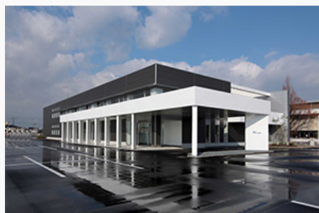
米子オペレーションセンター（鳥取県米子市）
