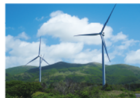
リエネ松前風力発電所
