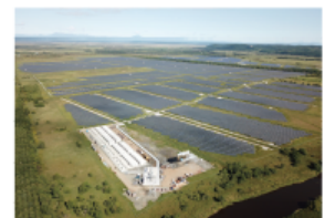
すずらん釧路町太陽光発電所
