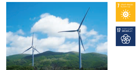
リエネ松前風力発電所 (2019年4月運転開始)
