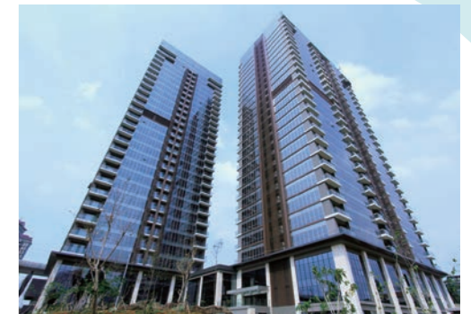
BRANZ SIMATUPANG (2018年12月竣工)
