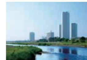
二子玉川ライズ タワー&レジデンス (2010年竣工)
