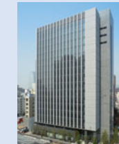
新橋東急ビル 所在地:東京都港区 竣工:2008年4月
