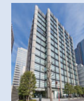
内幸町東急ビル 所在地:東京都千代田区 竣工:2006年7月
