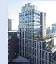
新目黒東急ビル 所在地:東京都品川区 竣工:2012年12月
