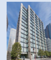
内幸町東急ビル 所在地:東京都千代田区 竣工:2006年7月
