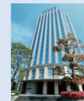
恵比寿プライムスクエアタワー 所在地:東京都渋谷区 竣工:1997年1月
