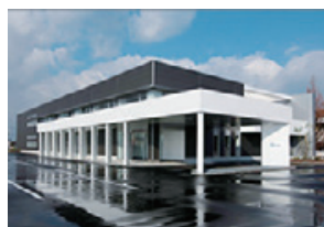
米子オペレーションセンター (鳥取県米子市)
