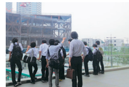
建設現場を見学する中学生
