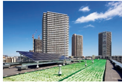
ブランズ東雲の屋上緑化と太陽光発電設備
