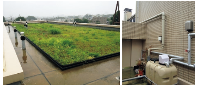
屋上に降った雨をためて庭園の散水に利用
