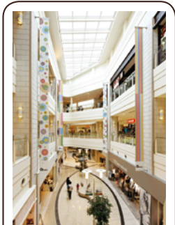
インモールのトップライトによる昼光利用と、ダウンライトにLED照明を採用することで電力量を削減。
