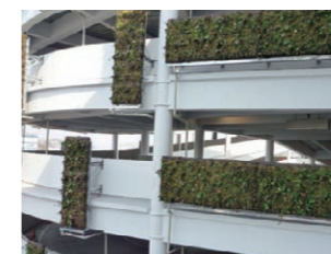
壁面緑化(戸塚東急プラザ)
