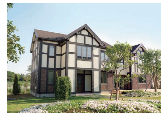
ケミレスタウン内(株)東急ホームズ実験住宅
