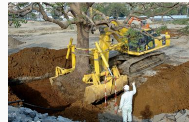
TPM機械による移植作業
