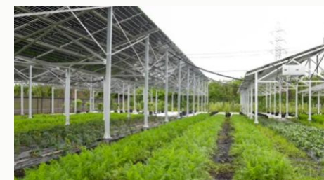
太陽光パネルとその下での植生管理 (リエネソーラーファーム東松山)
