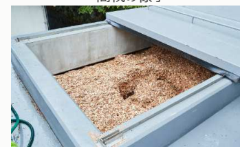
バイオマスボイラー
